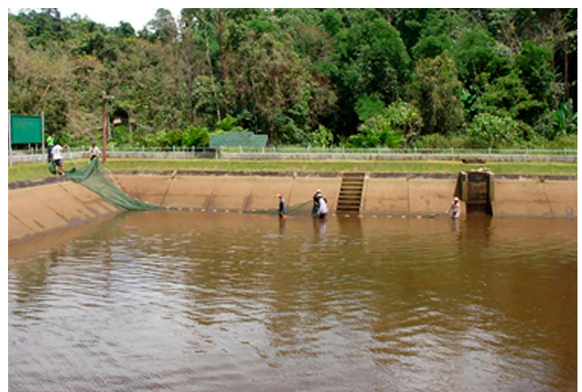
Рис. 3. Бетонный бассейн для выращивания сибирского осётра; станция Pangtong провинции Mae Hong Son, Королевство Таиланд
